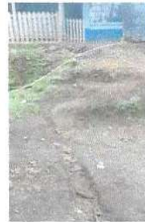
Foto 4: se observa el mal ambiente por el agua residual de la cocina, y la necesidad de la colocación de tuberías hasta la fosa séptica
